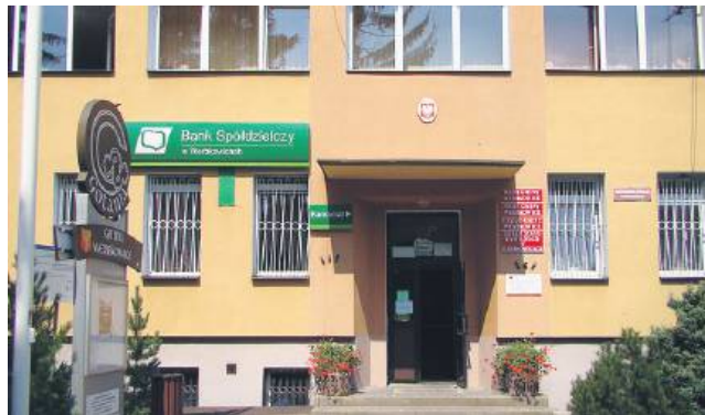
Urząd Gminy Werbkowice utracił dostęp do części systemów informatycznych oraz baz danych zawierających dane osobowe.
