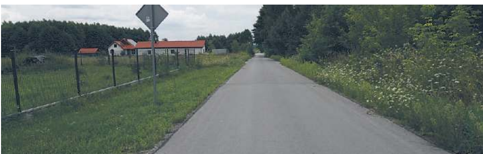
W 2020 roku gmina Sawin położyła 900 metrów asfaltu na skrzyżowaniu w miejscowości. Inwestycja kosztowała prawie pół miliona (240 tys. zł pochodziło z Funduszu Dróg Samorządowych)
