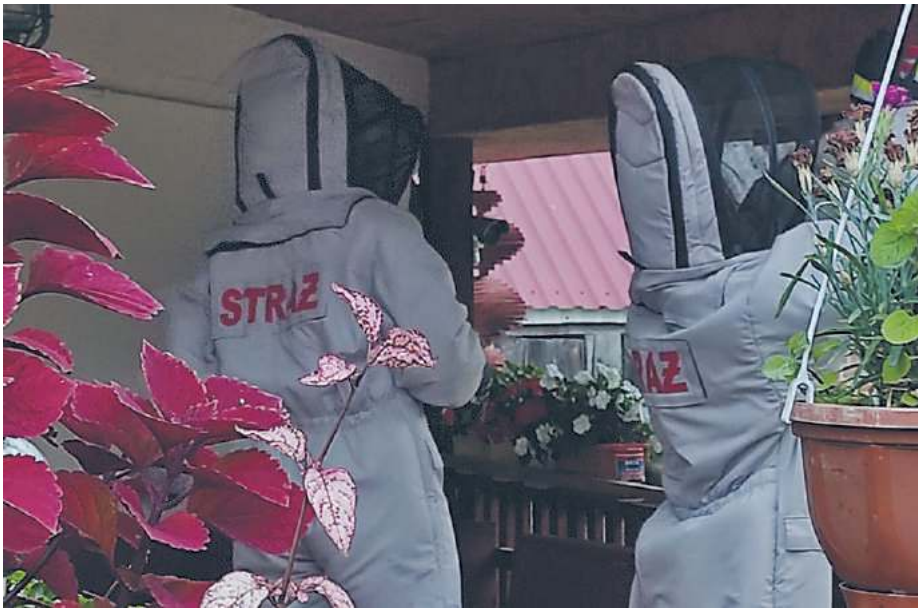
W ubiegłym tygodniu ubrani w specjalistyczne kombinezony strażacy usuwali owadzie gniazdo m.in. z domu w Majdanie Ostrowskim. W tym celu musieli rozebrać część podsufitki dachowej
