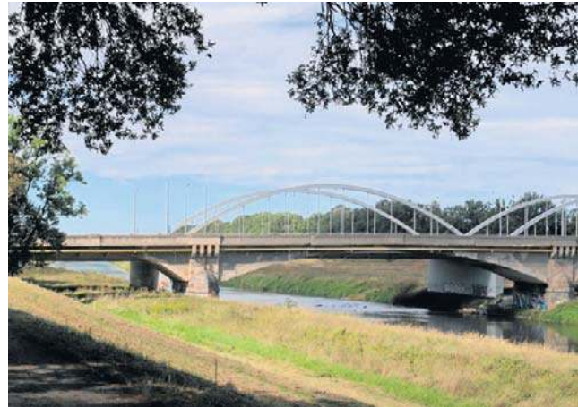
Dolnośląski Wojewódzki Konserwator Zabytków odmówił wykreślenia mostów z wojewódzkiej ewidencji zabytków.
