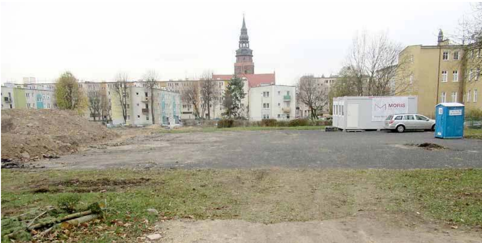
Plac budowy hali nadal wygląda tak jak 21 listopada, gdy robiliśmy to zdjęcie
