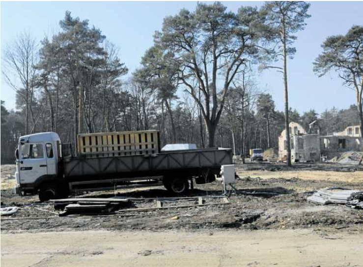
• Dwór Bojarów w Otwocku zostanie odbudowany, a wokół niego powstanie osiedle mieszkaniowe FOT. JACEK MARCZEWSKI / AGENCJA WYBORCZA.PL
