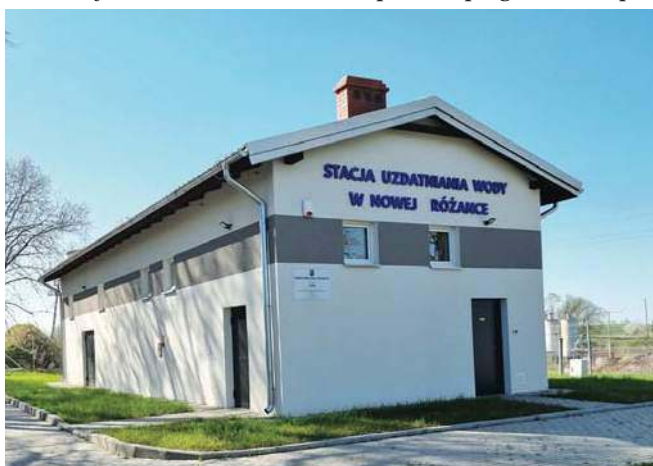
Stacja uzdatniania wody w Nowej Różance
