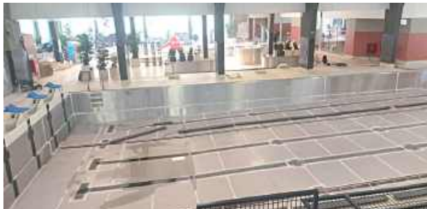
Wewnątrz inwestycja jest już na ukończeniu
