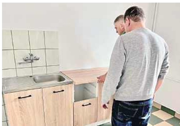
W przedszkolu przy ul. Klonowej trwa montaż kuchni oraz składanie mebli
