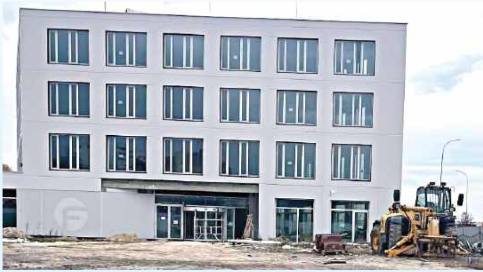
Budowa u zbiegu ulic Wyszyńskiego i Legionów w Zamościu ma być ukończona
