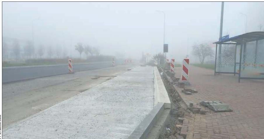
Podczas prac remontowych na al. Piłsudskiego naprawiane są między innymi zatoki autobusowe
