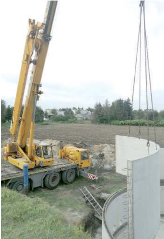
Trwa budowa nowego ujęcia wody w Wohyniu
