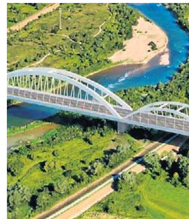
Zakończenie prac zaplanowano w sierpniu 2029 roku
