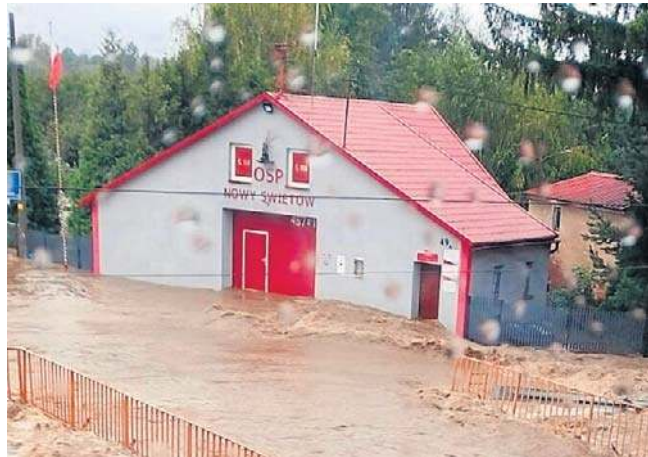
Wszystkie budynki mają powstać do końca przyszłego roku. Na zdjęciu remiza w Nowym Świątowie w 2024 r.
