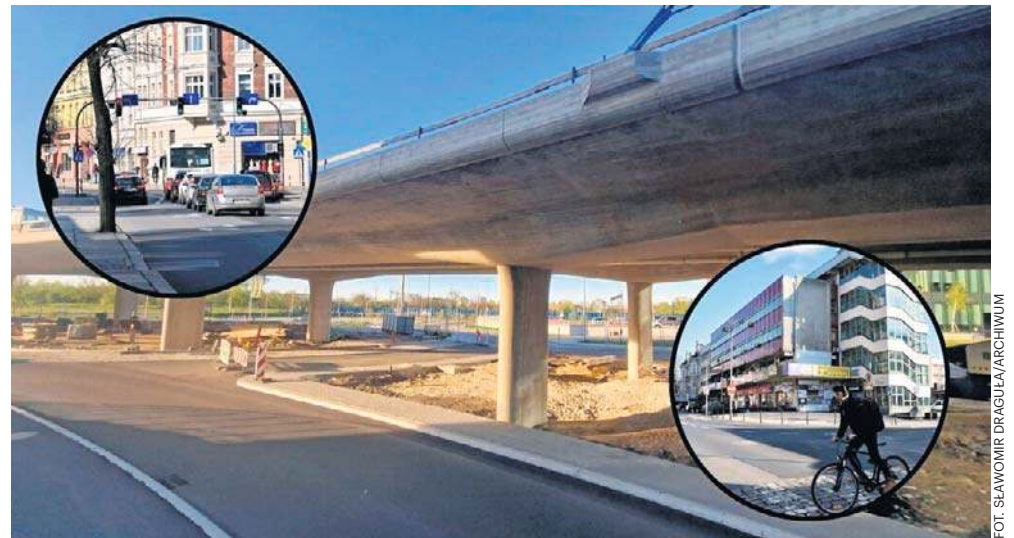
Po zakończeniu budowy estakady, ruszy przebudowa skrzyżowań w centrum Opola.
