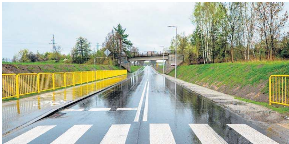
Nowa droga w Kłobucku już oddana. Milionowa inwestycja ma usprawnić ruch w mieście
