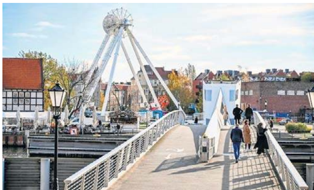
Konstrukcja koła wykonana została przez firmy z Holandii, Czech i Polski. Montaż niebawem!
