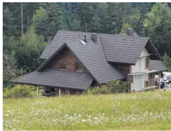
Samowola budowlana w Harklowej
