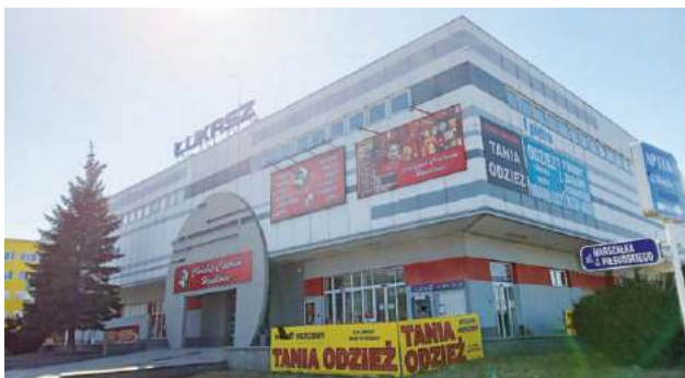
„Łukasz” ma być wyburzony, a na jego miejscu powstanie 5-kondygnacyjny blok mieszkalny z podziemnymi garażami.
