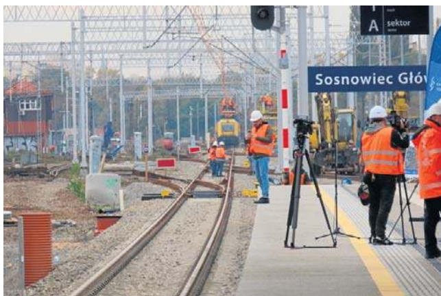
Na stacji Sosnowiec Główny powstał peron nr 3. To tam od 5 listopada przeniosą się podróżni
