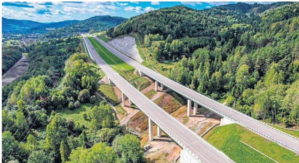
Obejście Węgierskiej Górki wreszcie gotowe. Jedną z najbardziej wyczekiwanych dróg na południu Polski - pierwsi kierowcy pojadą nią w czwartek
