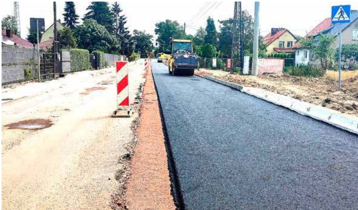
Na ulicy Lelewela ułożono już warstwy bitumiczne na części jezdni
