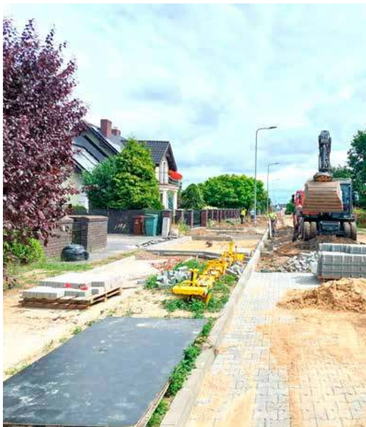
Do tej pory wykonano na Chełmońskiego ok. 300 metrów chodnika
