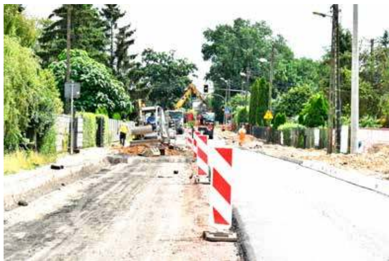
Na ulicy Lelewela trwa frezowanie drugiego pasa drogi
