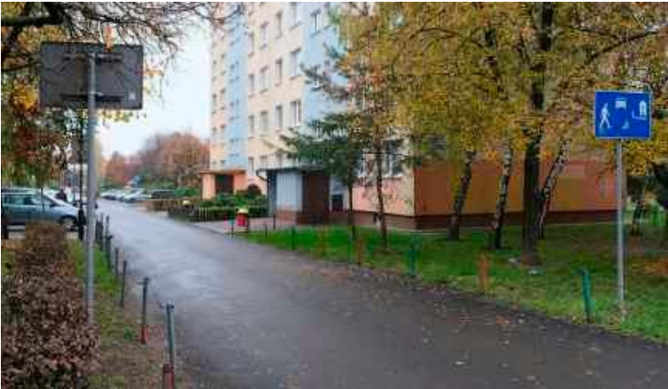
Z wyremontowanej drogi cieszą się nie tylko mieszkańcy bloku przy ulicy Pogodnej 38, ale także z ul. Jesiennej, którzy do domu nie muszą już wracać po wertepach
