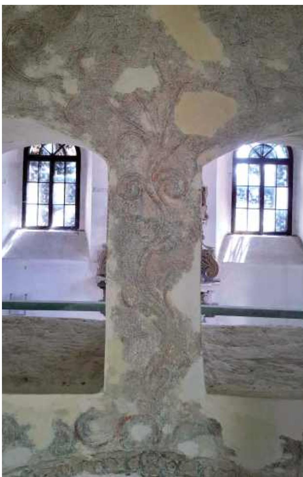
Podczas usuwania wtórnych tynków oraz nakładanych przez dekady warstw farby i pobiału w górnej części bimy, czyli podwyższonego podium służącego do czytania Tory, natrafiono na dobrze zachowane fragmenty oryginalnych malowideł
