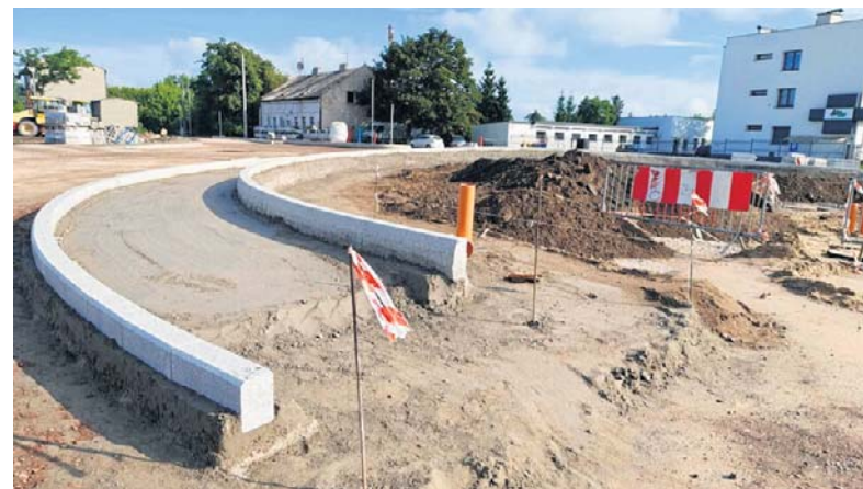
Trwa budowa ronda turbinowego przy Urzędzie Pracy we Włocławku. Tak przebiegały prace na początku sierpnia
