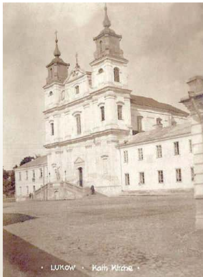
Zdjęcie wykonane w czasie I wojny światowej, najprawdopodobniej przez żołnierza niemieckiego. Kościół pw. Przemienienia Pańskiego, a zwłaszcza jego plebania były w trakcie przygotowań do Powstania Styczniowego głównym miejscem odbywania narad spiskowców. Oprócz księży Słotwińskiego i Brzóska w naradach brał udział rektor konwiktu Chrepiński i pozostali wikariusze Kożuchowski i Wydzga
