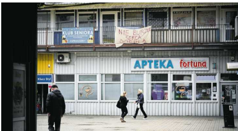
• Mieszkańcy nie chcą rozbiórki pawilonu przy ul. Pojezierskiej 2/6 w Łodzi FOT. MARCIN STĘPIEN / AGENCJA WYBORCZA.PL
