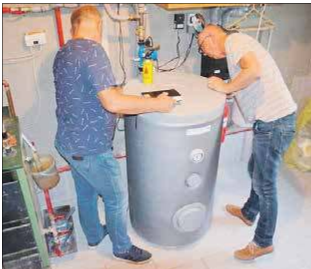
Kilka tysięcy domów jednorodzinnych na terenie powiatu parczewskiego zostanie wyposażonych w kolektory słoneczne, panele fotowoltaiczne lub piece opalane biomasą bądź gazem pozyskanym z drewna
