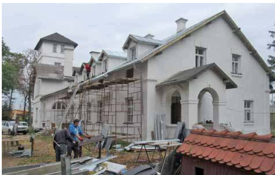
Właściciele już naprawiają dach
