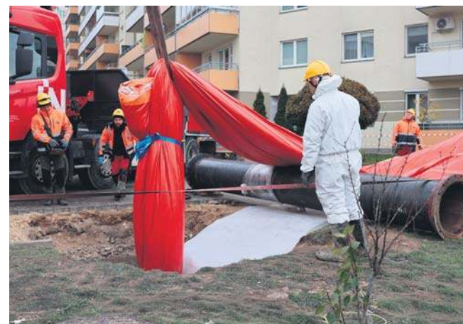
Modernizacja kolektora sanitarnego to korzyści dla mieszkańców i środowiska.
