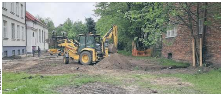
Trwa budowa placu zabaw przy Szkole Podstawowej nr 14 przy Al. Jachowicza 20
