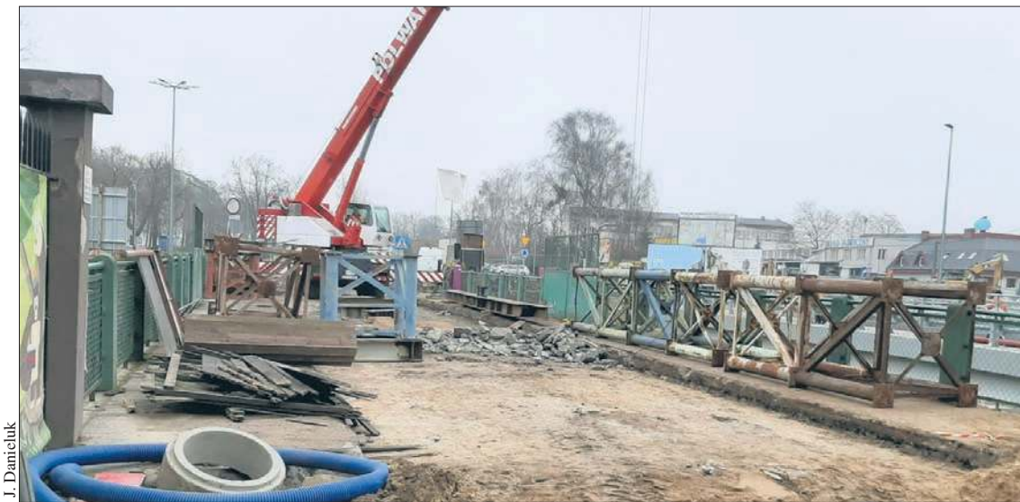
Prace przy wyburzeniu starego wiaduktu przy zoo powinny potrwać około dwóch tygodni, pod warunkiem, że pozwolą na to warunki atmosferyczne
