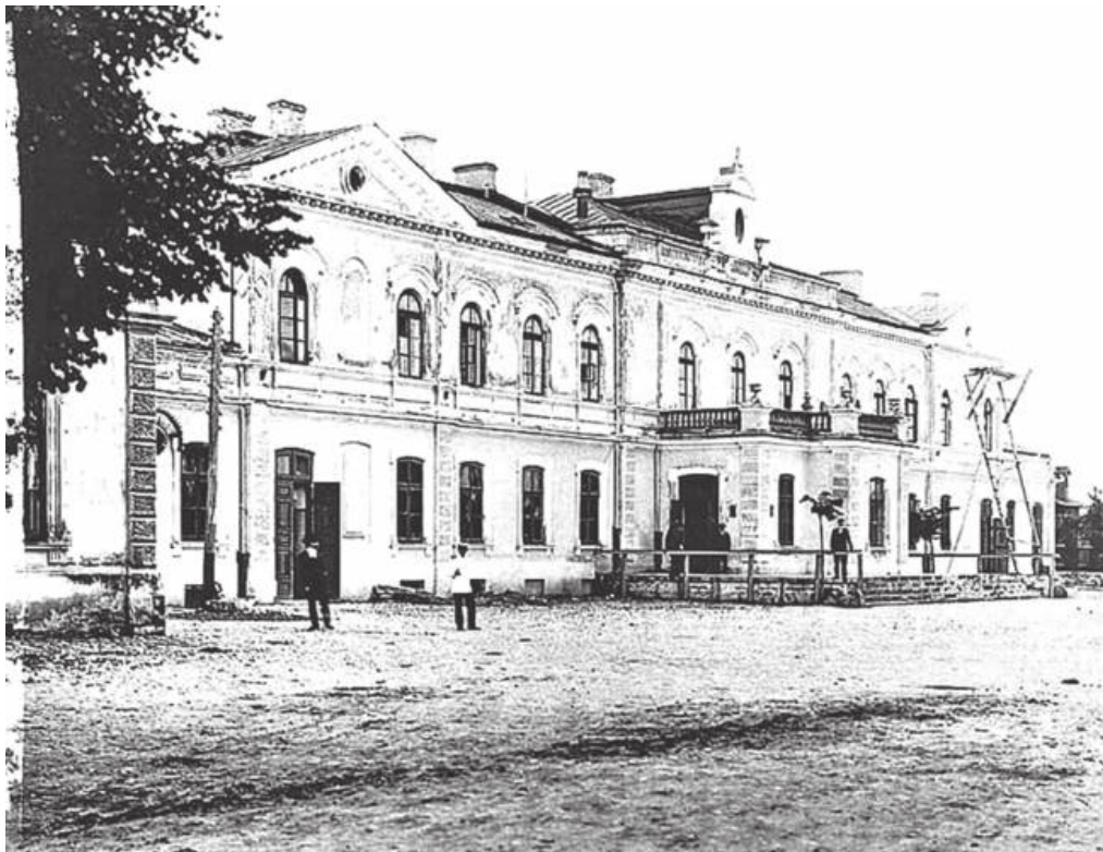
A tak wyglądał dworzec PKP Łuków przed 1915 r. fot. arch. Adolf Gancwol-Ganiewski
