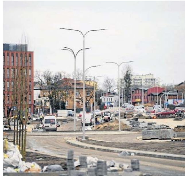
Budowa trasy staromostowej między ulicą Dekerta a Czerwoną Drogą - stan na połowę grudnia 2025 roku
