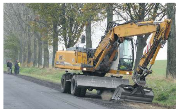
We wtorek, 29 października, rozpoczęto II etap przebudowy drogi ze Strzelina do Jegłowej. Wyremontowany będzie odcinek o długości 996 metrów
