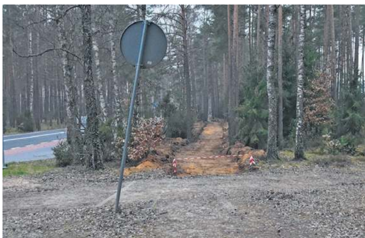
Prace związane z inwestycją już trwają.
