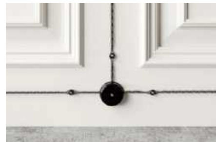
🔌 W wersji dekoracyjnej, najczęściej układa się przewody czarne, ale producenci oferują też wyroby w oplotcie w kilkudziesięciu kolorach. L. JAMPOLSKA, KOLOROWEKABLE.PL
