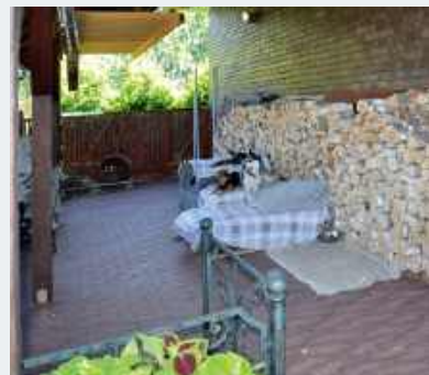
❷ Kostkę z klinkieru pozostawiono jedynie pod wiatą.
