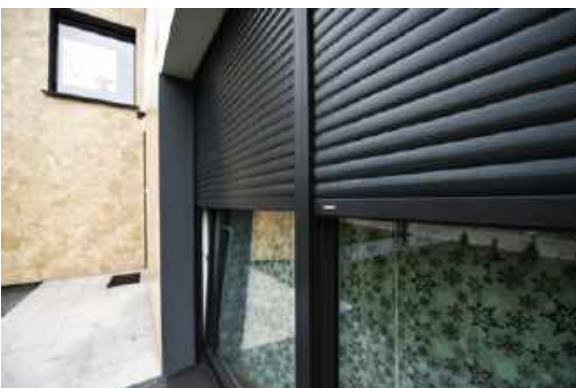
📍 Nowoczesne rolety podtynkowe z zabudowaną, niewidoczną kasetą. KRISHOME
