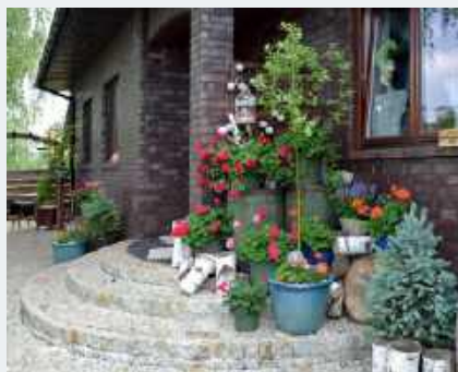
❶ Po demontażu bruku z klinkieru, ułożono granitowy.
