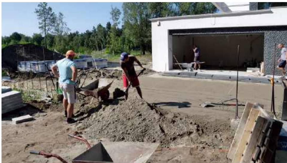
❗ Prace dookoła domu to po części wciąż roboty budowlane. A. PAPLIŃSKI
