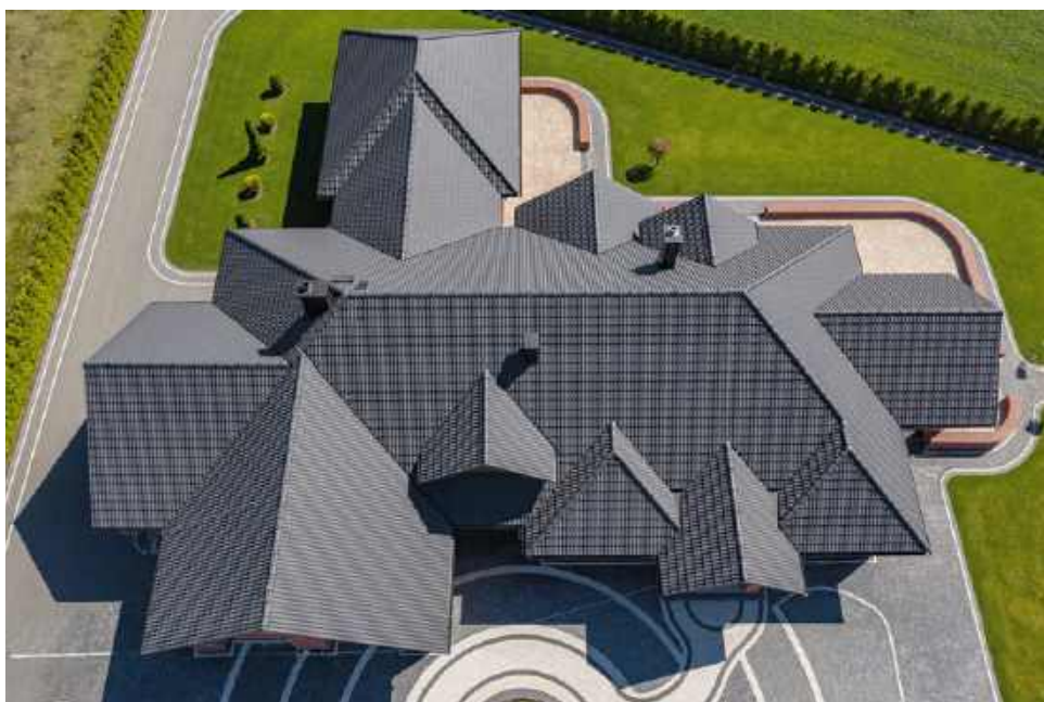
Dachówki cementowe są nieco tańsze i lżejsze od ceramicznych. Nadają się również do krycia dachów w o skomplikowanych kształtach. CREATON POLSKA
