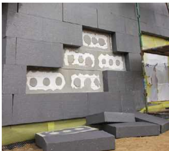
🔔 Szary styropian nie może być narażony na przegrzanie, bo płyty mogą odpaść od muru. ARCHIWUM P. KRAUSE
