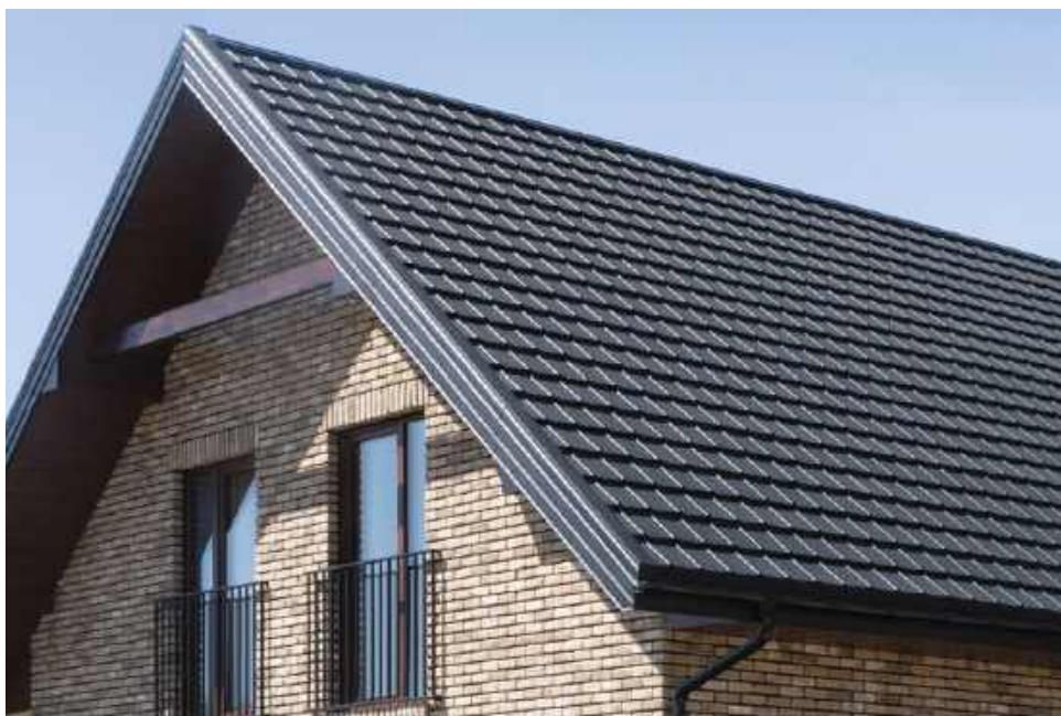
Blachodachówki powstają w wyniku tłoczenia arkuszy blachy w fakturę dachówek. To pokrycie o dobrym stosunku ceny do jakości. RUUKKI
