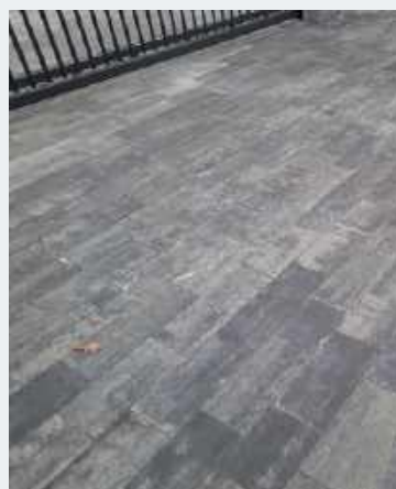
❶ Wszystkie twarde nawierzchnie na posesji wykończono bezfugową kostką z betonu.
