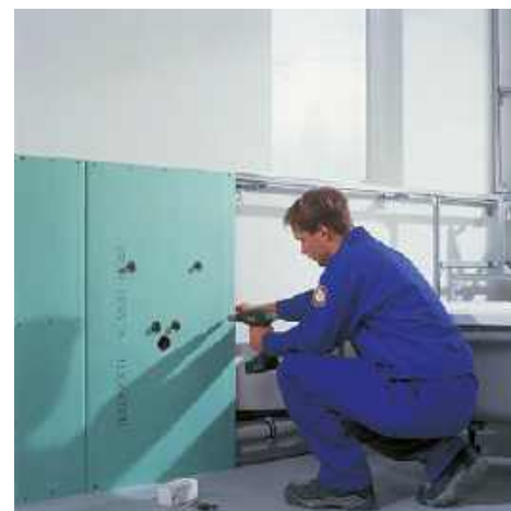
🔧 Obudowę stelaża wykonuje się najczęściej z płyt g-k. Ważne, żeby użyć produktów o zwiększonej odporności na wilgoć. TECE
