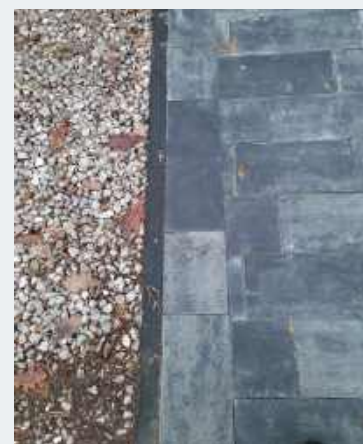
❷ Obrzeża wykonano z gęstego betonu, na którym umocowano gotowe krawężniki.
