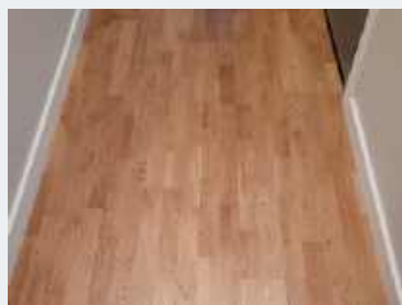
Warstwa ścierna z drewna dębowego ma grubość 2,5 mm.
