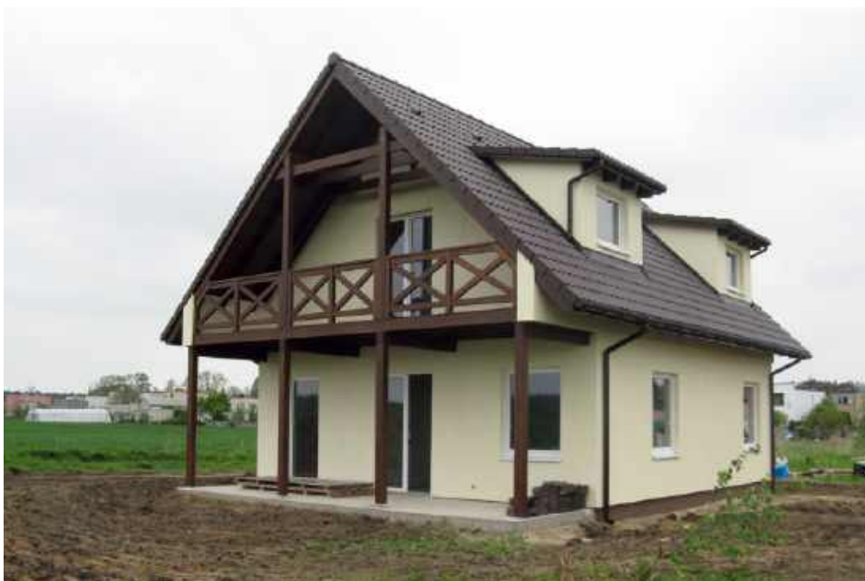
Bez pozwolenia, kierownika i dziennika budowy można postawić dom o powierzchni zabudowy do 70 m 2 . ARCHIWUM BD
