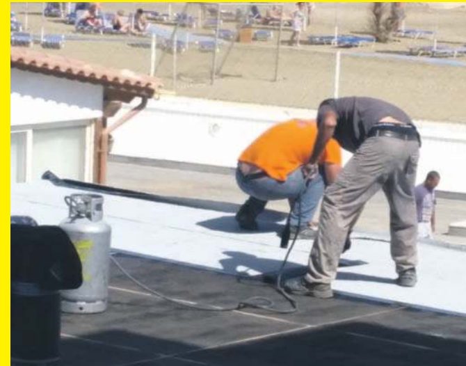
Cały dzień kładziono papę na dachu przy basenie
