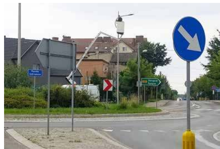
Prace prowadzone przy rondzie Sybiraków w czwartek rano
