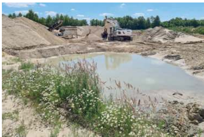
Zdjęcie wykonane w trakcie kontroli PINB Biała Podlaska w czerwcu 2021 r.
