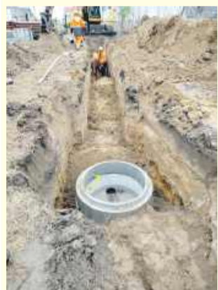
Na ul. Gajowej w Wiszni Małej wykonano ponad 354 metry kanału sanitarnego
