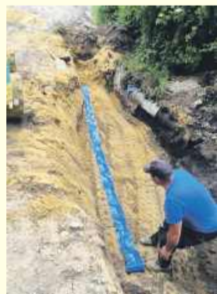
Na ul. Szkolnej w Wiszni Małej wykonano blisko 927 metrów nowej sieci wodociągowej
