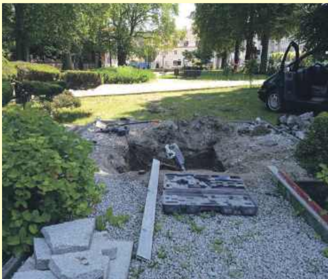
Pomimo upałów trwają prace przy fundamentach pomnika.
