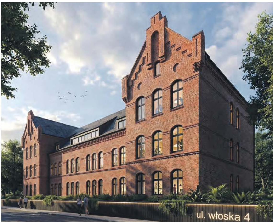
W budynku znajdują się około 22 mieszkania
