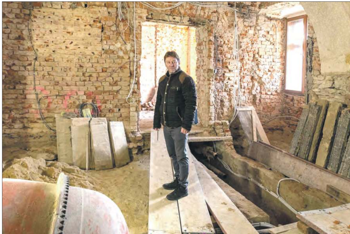
Starosta Martin Korduliak ogląda remontowanych pomieszczeń zamku
