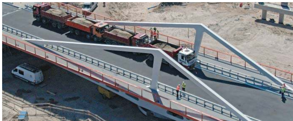
Czerwiec na budowie przekopu
