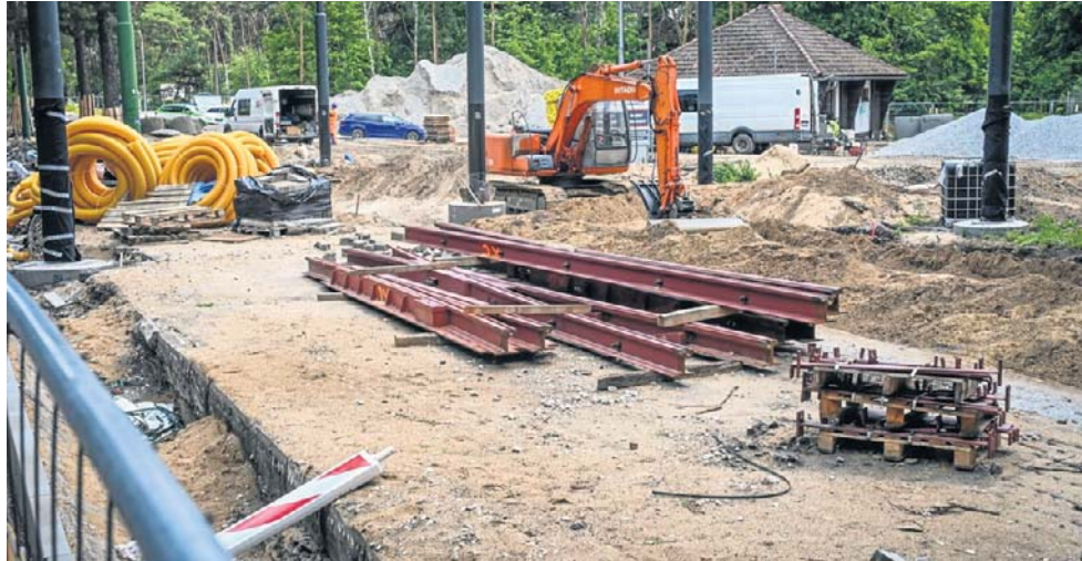
Trwa przebudowa pętli tramwajowej Las Gdański. Wykonawca zamontował już też część słupów trakcyjnych i rozpoczął montaż torów oraz rozjazdów najazdowych
