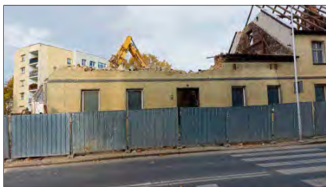
Rozpoczęto wyburzenie starych budynków przy ulicy Prudnickiej w centrum Krapkowic – teren przygotowywany jest pod nowy kompleks usługowo-mieszkalny.
