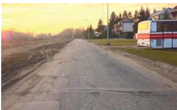
Ulica Kusocińskiego prowadzi do budowanego od kilku miesięcy odcinka, który będzie połączony z ul. Radzyńską
