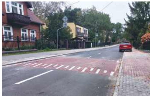
Ulica Złota na III Parceli po remoncie.
