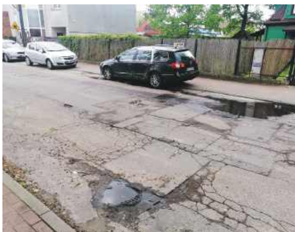
Ulica Henryka Sienkiewicza przed remontem.
