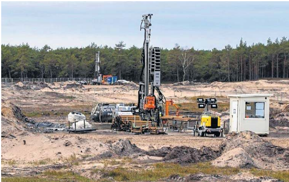
Polska firma Elektrotim zapewni zasilanie placu budowy elektrowni jądrowej
