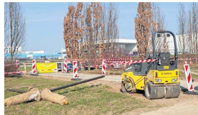
Maszyn, które przyjechały na plac budowy łącznika, musiały odjechać
