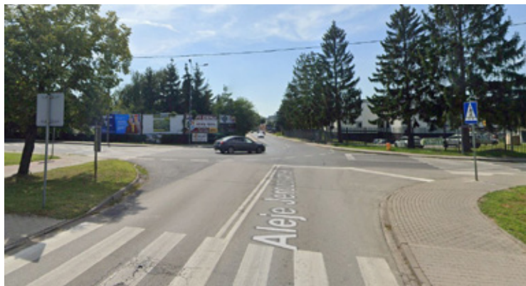
Skrzyżowanie ulic Alei Jeruzolimskiej, Mostowej i Naborowskiej
