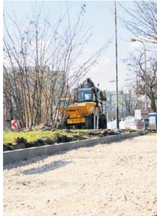
Droga wzdłuż ulicy Dąbrowskiego już powstaje
