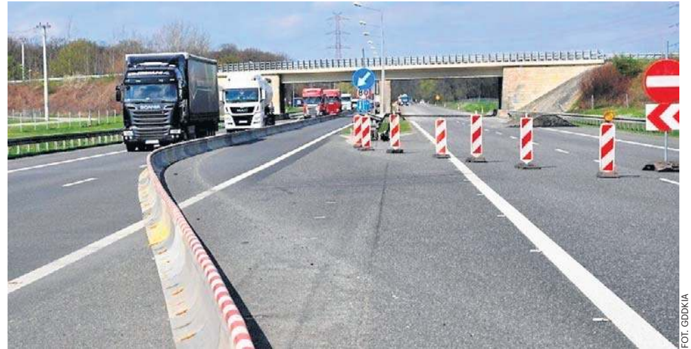
W trakcie poszerzenia autostrady ruch ma być prowadzony na dwóch pasach
