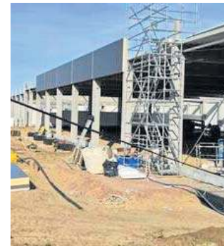
Trwa budowa pierwszej galerii handlowej w Łęczycy
