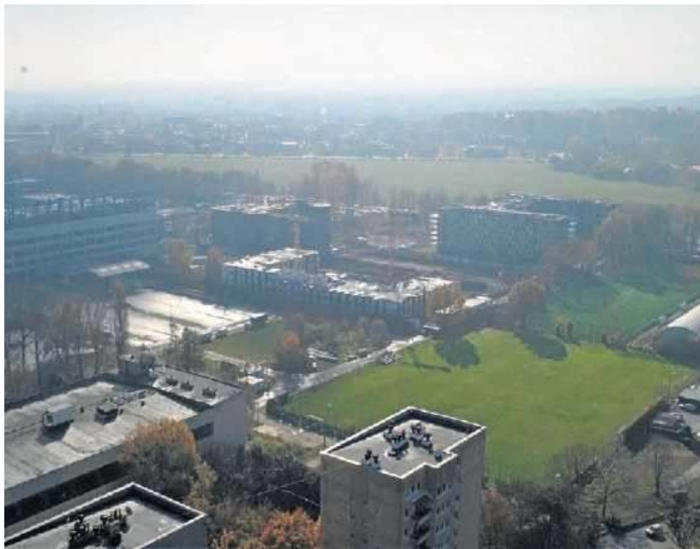
Nowy budynek powstaje w miejscu dawnego, historycznego stadionu miejskiego
