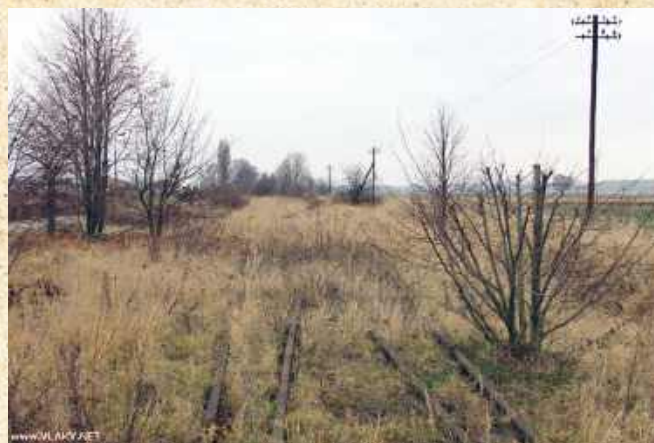
■ Linia kolejowa w Krzanowicach jest dziś już kompletnie zarośnięta
