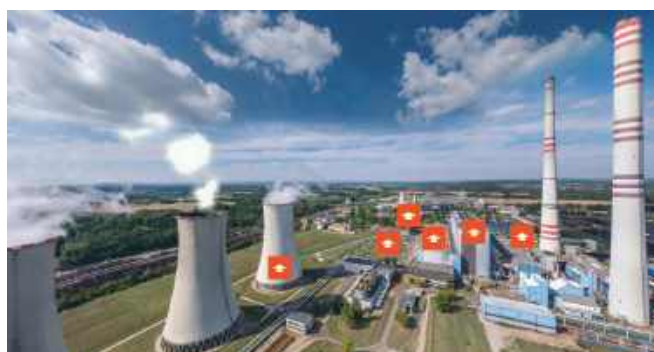
■ Elektrownia w Dzieńmorowicach (Dětmárovice) w Kraju Morawsko-śląskim w Czechach. FOT. GRUPA ČEZ
