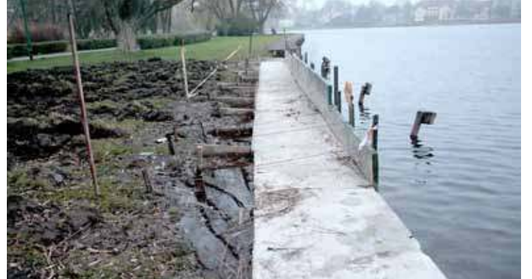
Jak widać prace zakończono na etapie wylania nowego murku, na którym zostanie wybudowany pomost
