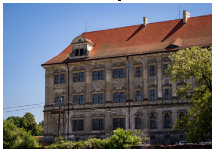
Fasada obiektu przytłacza ogromem.
